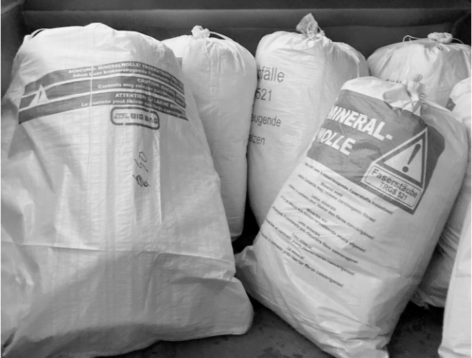
Staub- und luftdicht verpackte Mineralfaser-Abfälle in zertifizierten Säcken.
