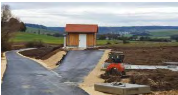
Der Verbandskanal beginnt am neu errichteten Regenüberlaufbecken Katzenstein der Gemeinde Dischingen und verläuft in der frisch asphaltierten Straße zum Härtsfeldsee.
