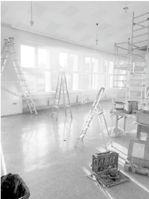
Renovierungsarbeiten im Gundelfinger Pfarrheim
