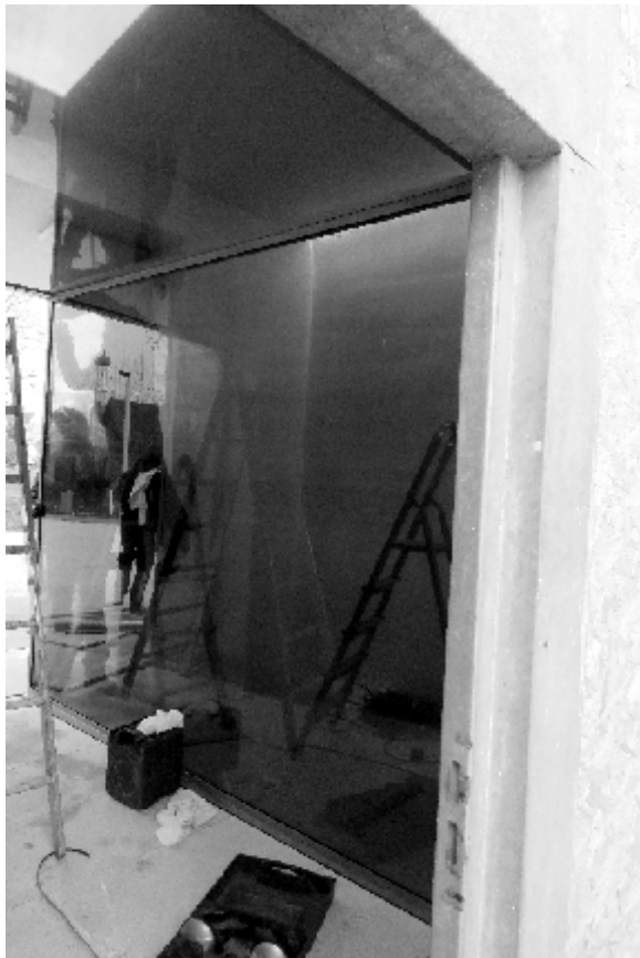
Für das Glaskunstwerk am Friedensdenkmal wurden von der Bayerischen Hofkunstanstalt drei große Glasscheiben eingebaut. Text/Bilder: Stadt Gundelfingen
