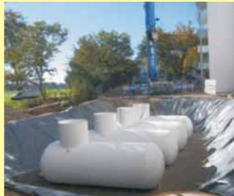
In diesen Tanks wird das synthetisch hergestellte Erdgas gespeichert und dann bei Bedarf die BHKWs im Wohnblock zur Wärme und Stromproduktion betrieben
